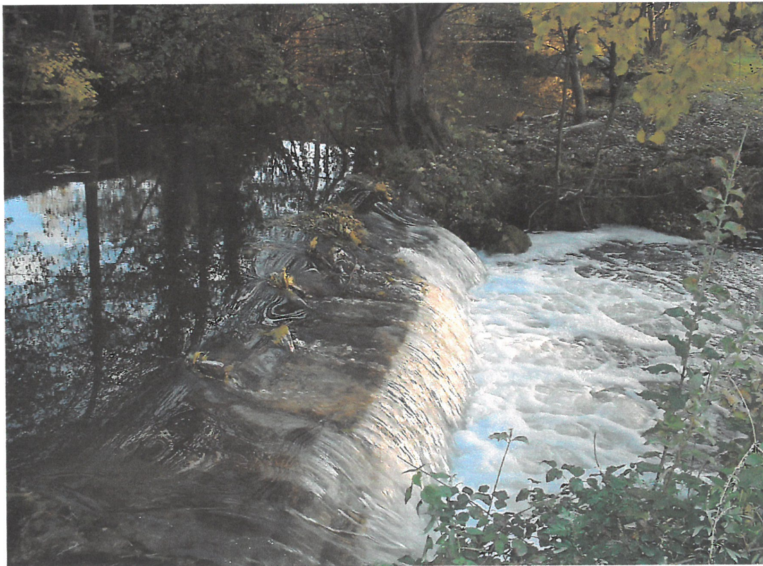
Déversoir à modifier au niveau du moulin du Gravier.
