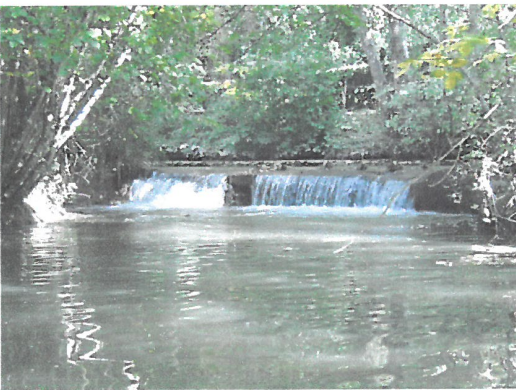
Déversoir vue de l'aval
