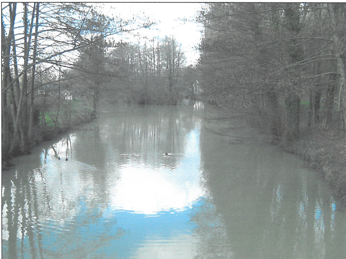
Retenue d'eau en amont du clapet du camping de Château-Renault.
