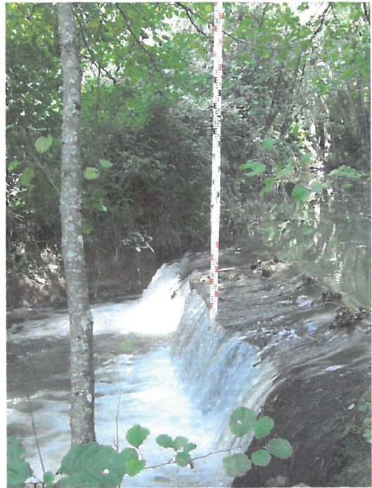
Déversoir à aménager
